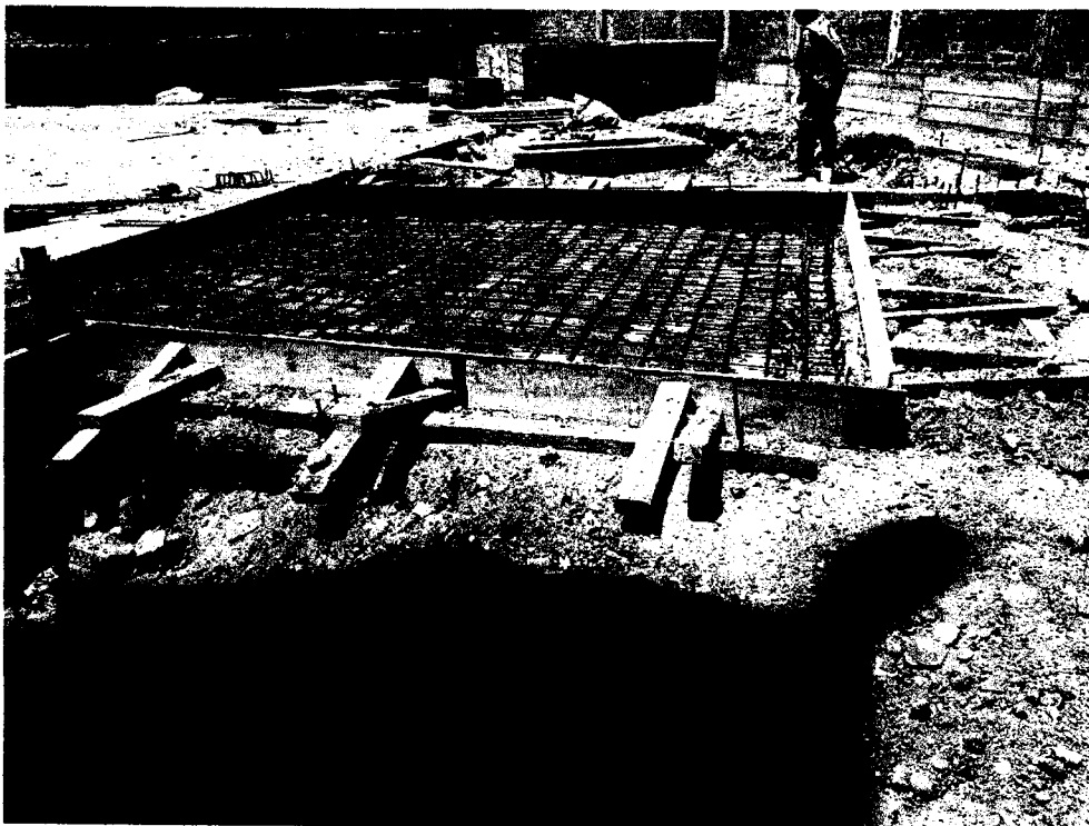
Fig. 09 Habilitación de acero y encofrado para losas de patio de maniobras.
