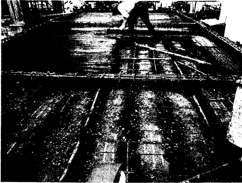
Fig. 03 Habilitación de acero fy=4200 kg/cm2 y encofrado para vigas del tanque elevado
