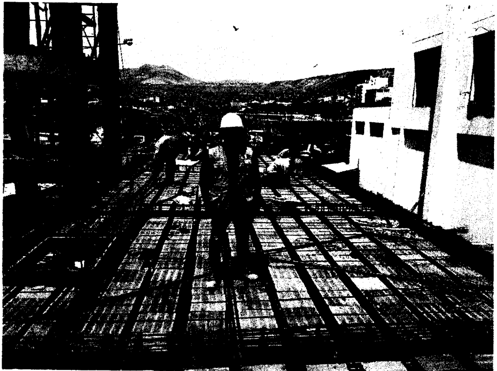
Fig. 02 Losa aligerada del área de talleres con instalaciones eléctricas y sanitarias
